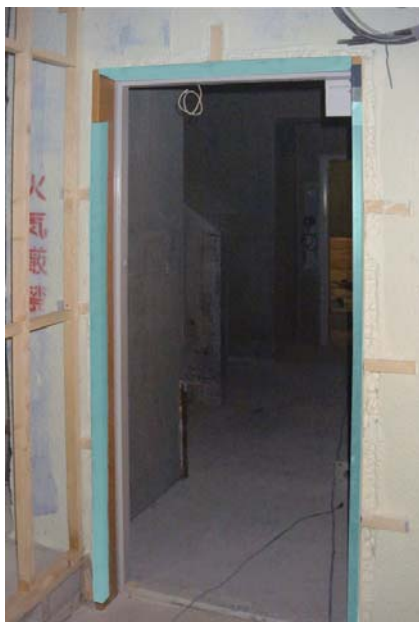
●施工したままでクロスが貼れ、 ドアの開閉ができます。
