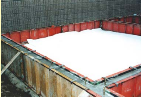
ベタ基礎に施工
