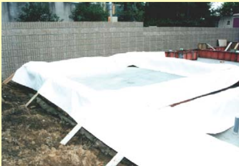
布基礎に施工
