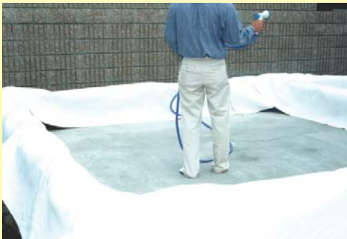
夏場は施工後、散水する
